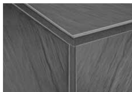
Wykonanie naroży z docinaniem profilu na skos
